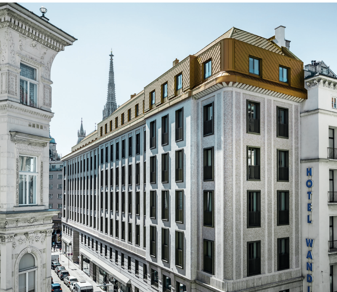
Drei einzelne Gebäude werden durch die goldene Aufstockung unter einem Dach vereint.
