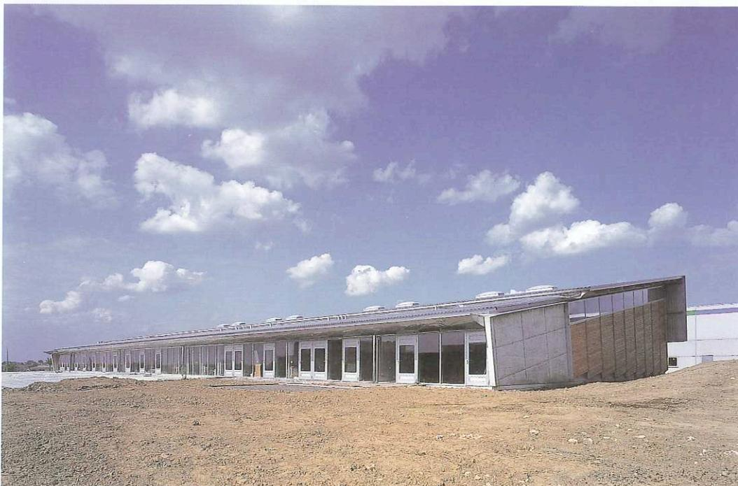
**Die Kommissionierhalle einer Möbelfirma in einem kleinen Dorf zwischen Soester Börde und Sauerland öffnet sich zum Ladehof zweigeschossig, zur freien Landschaft dagegen eingeschossig. Der Baukörper hat nicht einfach „nur“ ein geneigtes Dach, sondern er wird als Volumen aufgefaßt, das „im Boden versinkt“. Dementsprechend ordnen sich auch die Holzverkleidungen der Stirnseiten dieser Geometrie unter**
