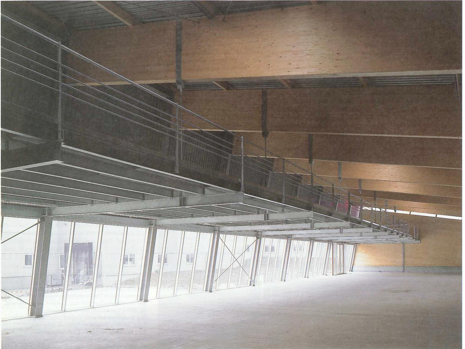
**Eine Galerie im Inneren der Halle ist mit stählernen Zuggliedern an den Brettschichtbindern abgehängt. Hier oben lagern Kartonagen. Grundriß und Schnitt im Maßstab 1:1000. Fotos: Ralph Richter/Architekturphoto, Dortmund**
